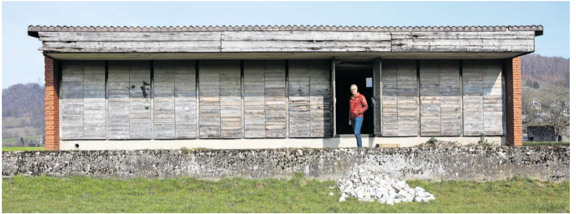
Nächstens sollen die Sanierungsarbeiten am ehemaligen Schützenhaus beginnen. Im Frühjahr 2022 soll das Kompetenzzentrum eröffnen.
